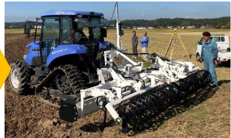
③ レーザーレベラーで均平
