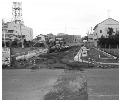
▶ 工事が進む大原駅前線
