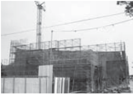
▲建設が進む岬中学校
