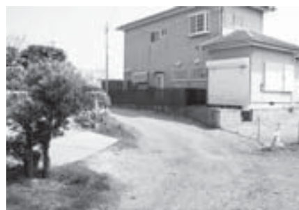
▲舗装補修工事が行われる南町地先
