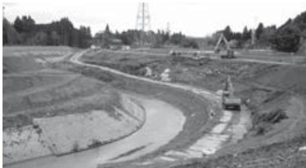
改修の進む落合川 (新田野地先)
