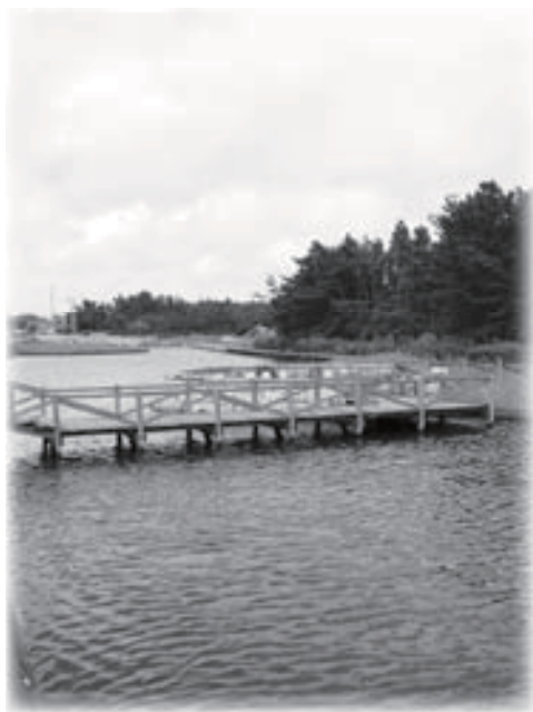
▲改修を行うボードウォーク (日在浦海浜公園)
