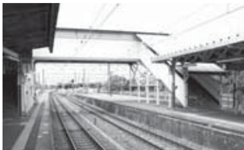
▲エレベーターが設置される大原駅構内
