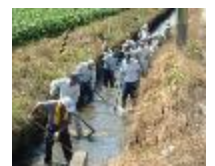
水路の泥上げ
