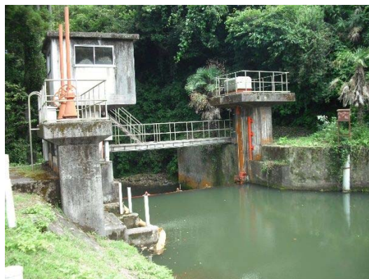
大野浄水場(取水施設)
