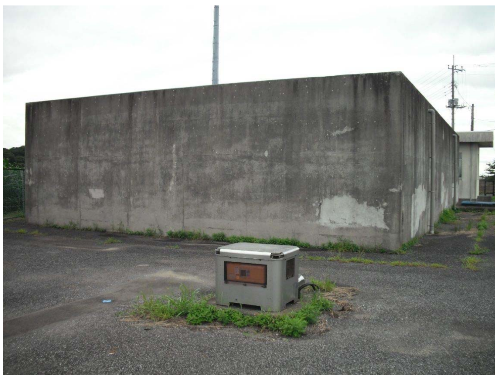
須賀谷 RC 配水池
