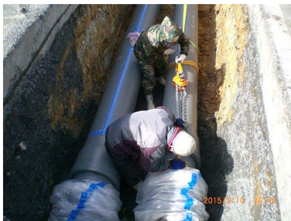
GX 形管路の埋設状況
