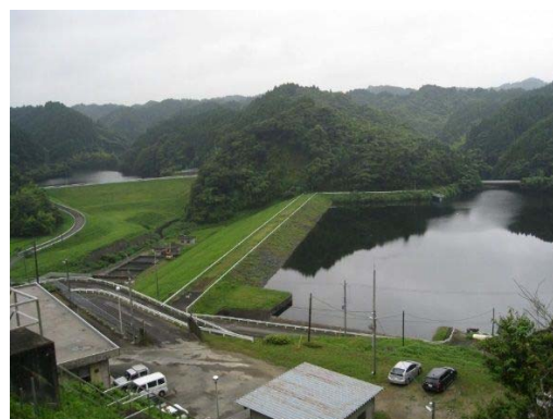
東ダム(山田浄水場)
