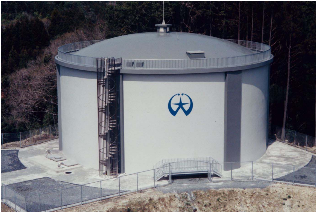
大原配水場 (PC 配水池)
