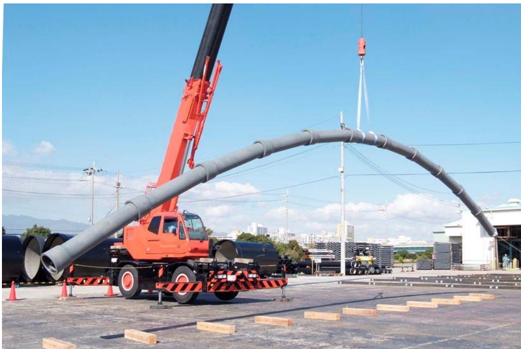
GX 形管路の吊り下げ状況
