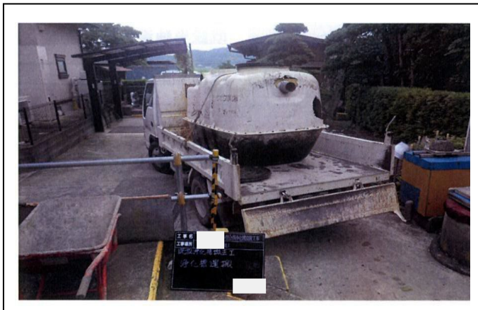
(4-6) 撤去工事完了作業写真
