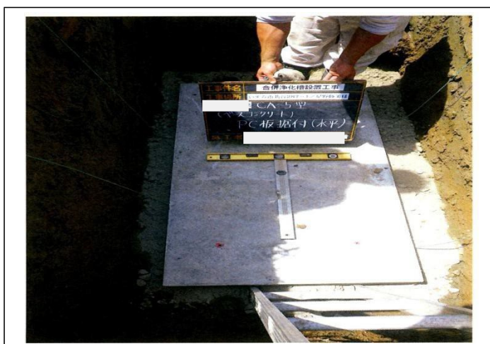
(7) PC板設置工事に係る写真 寸法の検測状況写真 設置後の水平が確認できる写真
