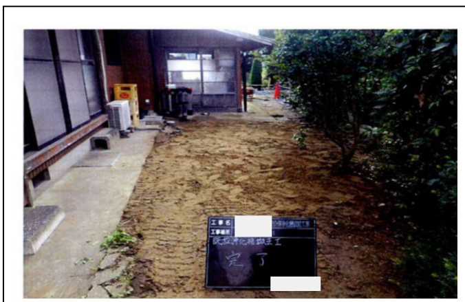
(4-5) 埋め戻し作業
