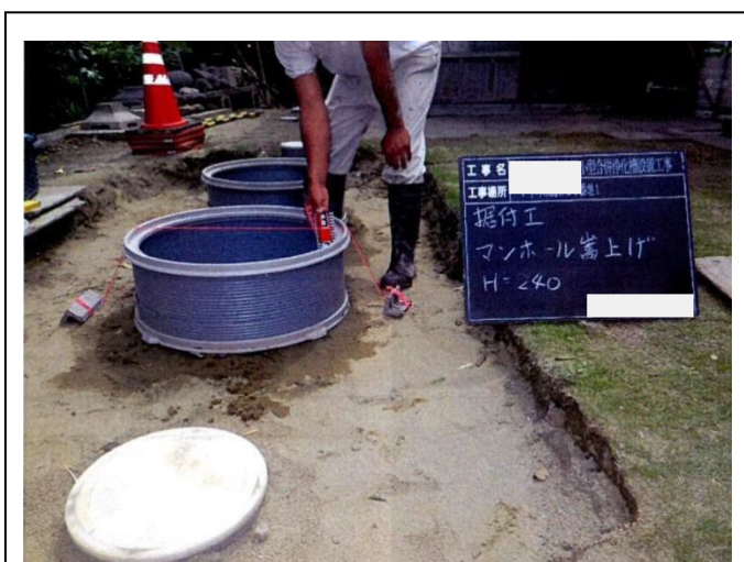
(13) 嵩上げ状況 検測状況者写真
