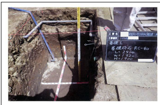
(3) 浄化槽底部の基礎状況（目潰し碎石） 検測状況を示すこと
