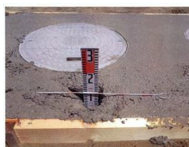
(12) 浄化槽上部の基礎状況（配筋） 検測状況写真
