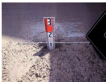
(6) 浄化槽底部の基礎状況 (基礎コンクリート) 検測状況を示すこと
