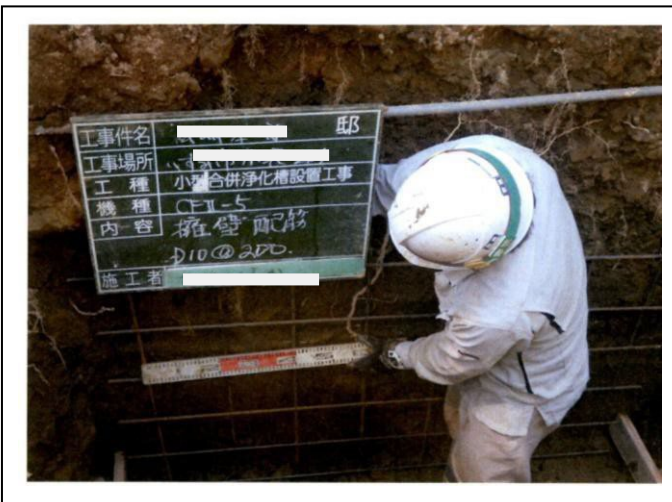
(10) 擁壁の状況 (必要な場合)
