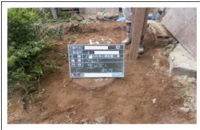
(11-4) 埋め戻し転圧状況
