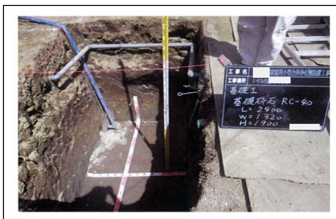
(3) 浄化槽底部の基礎状況（目潰し砕石） 検測状況を示すこと
