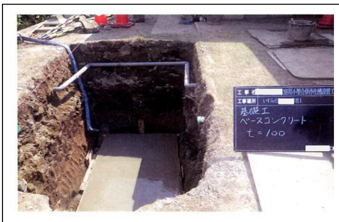
(6) 浄化槽底部の基礎状況 （基礎コンクリート） 検測状況を示すこと
