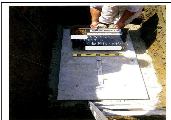
(7) PC板設置工事に係る写真
