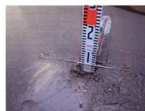
(4) 浄化槽底部の基礎状況（捨てコン） 検測状況を示すこと
