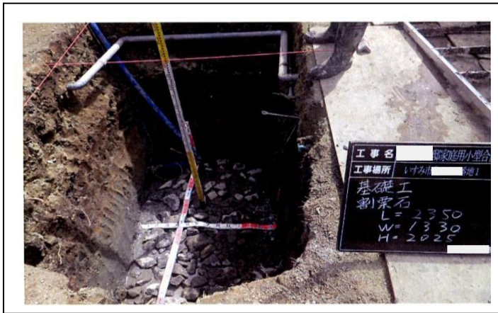
(2) 浄化槽底部の基礎状況（割栗） 検測状況を示すこと
