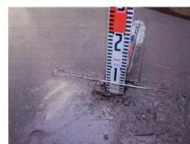
(4) 浄化槽底部の基礎状況（捨てコン） 検測状況を示すこと
