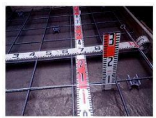
(5) 浄化槽底部の基礎状況 (配筋) D10@200 スペーサーを使用すること 検測状況を示すこと
