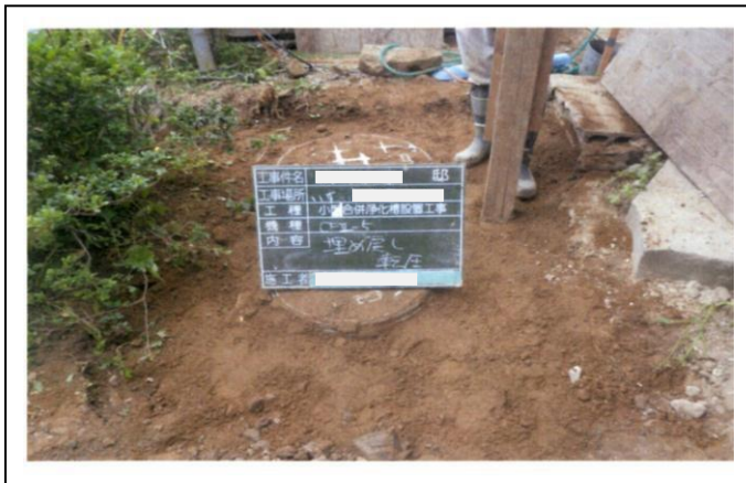
(11-4) 埋め戻し転圧状況
