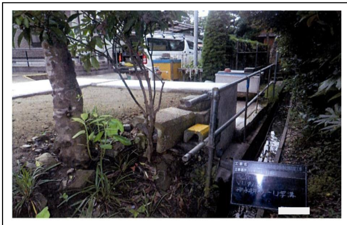
(3-2) 放流先状況写真
