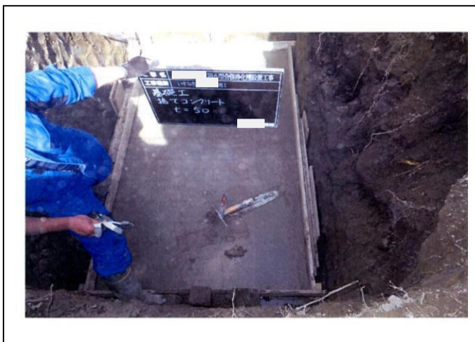
(4) 浄化槽底部の基礎状況（捨てコン） 検測状況を示すこと
