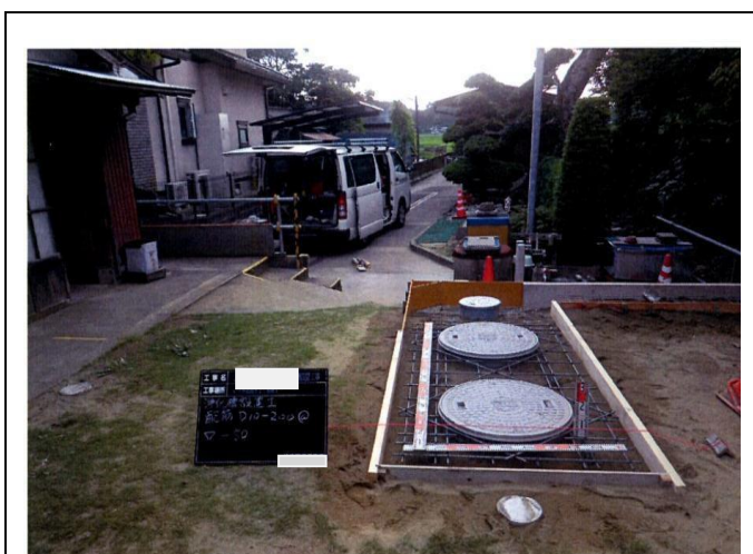
(12) 浄化槽上部の基礎状況 (配筋) 検測状況写真
