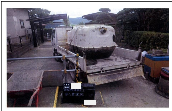
(4-6) 撤去工事完了作業写真
