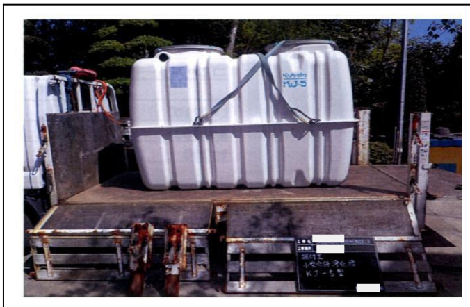
(8) 浄化槽本体写真
