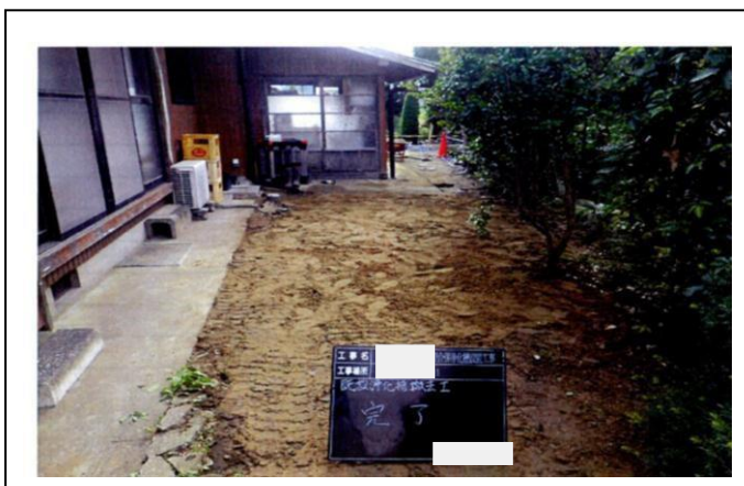
(4-5) 埋め戻し作業
