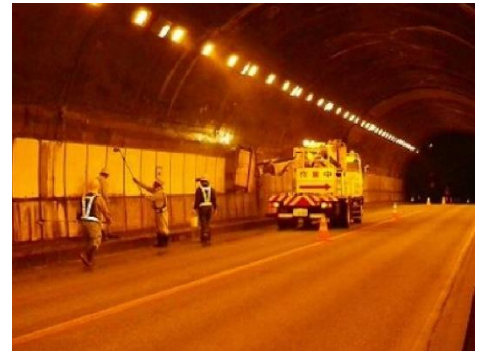
清掃作業の状況
