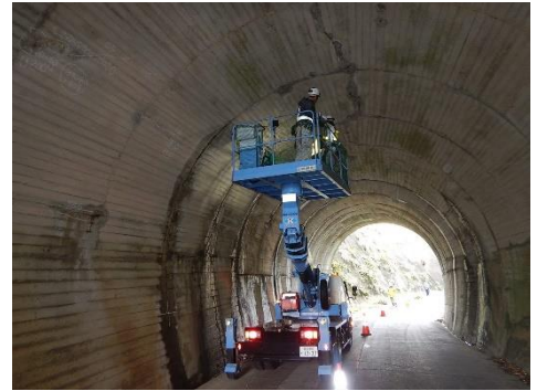
定期点検の状況
