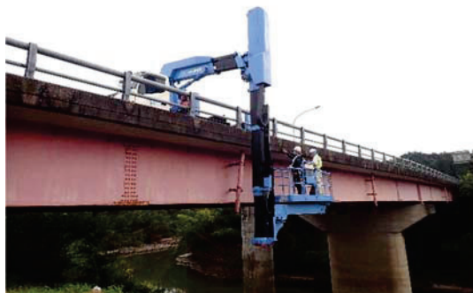
写真 1-4-1 橋梁点検車（新荻谷橋）
