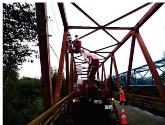
写真 1-4-2 高所作業車（音羽橋）
