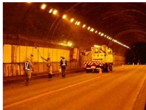
清掃作業の状況
