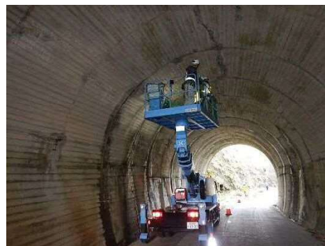
定期点検の状況
