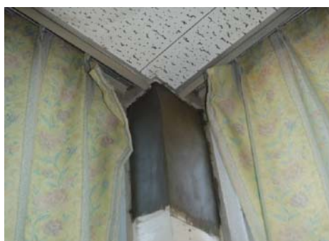
モルタル補修
