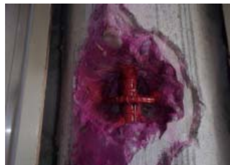
錆び止め塗布
