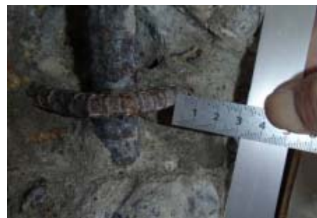
鉄筋かぶり厚さの測定
