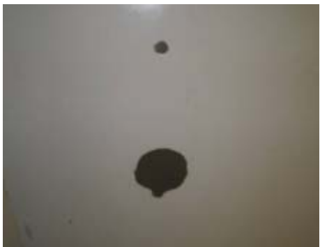
モルタル補修
