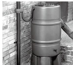
雨水活用タンク
