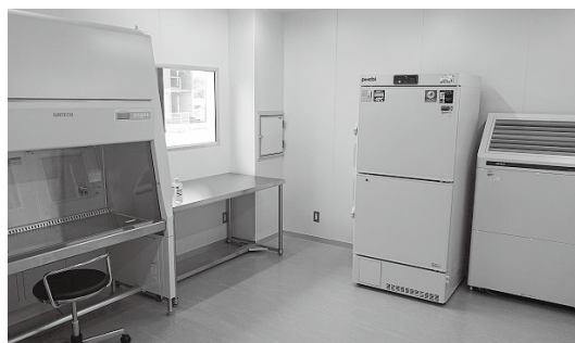
▲陰圧検査室内部
