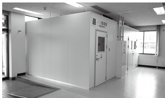
▲陰圧検査室外部
