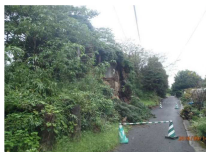
②立木が倒壊し、道路を一部塞いでいる
