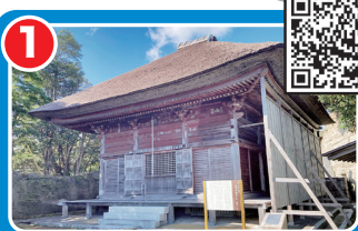
大聖寺不動堂「波切不動尊」 （重要文化財：建造物）
