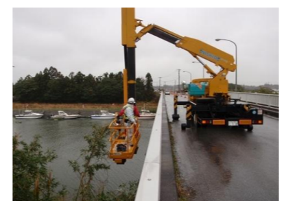
橋梁点検車による点検のイメージ
