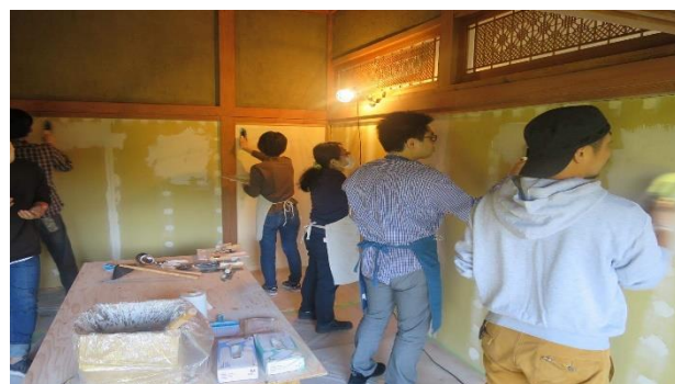
空き家の改修の様子
