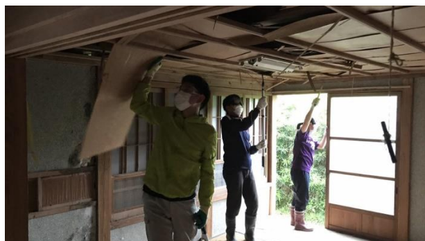
空き家の改修の様子
