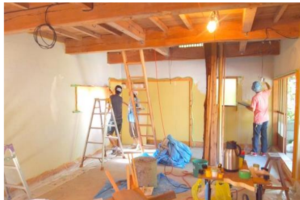
【改修中】 壁貼り、壁塗りの様子
